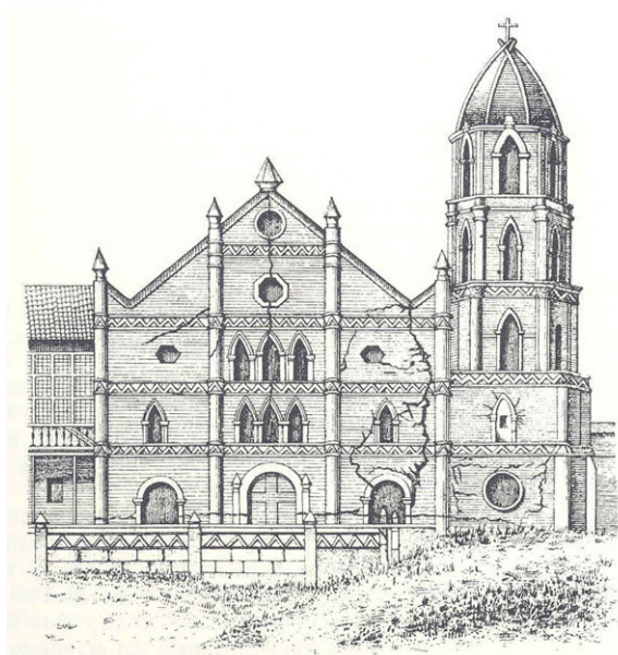
Figura 2. Efectos del terremoto de 1880 en la Iglesia de San Jacinto en Pangasinan (Filipinas). (Cerero, 1890).
