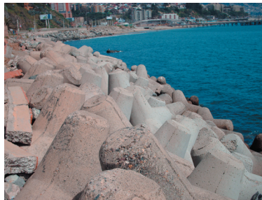
Figura 2. Autoafinidad de la arquitectura costera. Tradicionalmente las rocas son las principales estructuras naturales con las cuales se puede disipar el oleaje del mar. Aurbrey Kruger en 1966, imitando la naturaleza, diseñó bloques de concreto llamados "Dolos" que reproducen la organización y funcionalidad de un roquerío.
