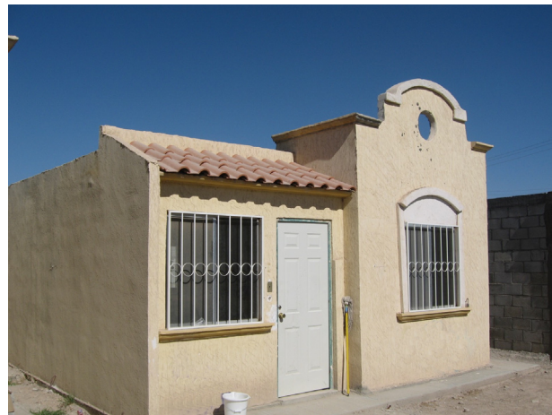
Figura 9. Casa modelo en Torreón Coahuila diseñada y construida como parte del proyecto de Meccano con CIE-UNAM.
